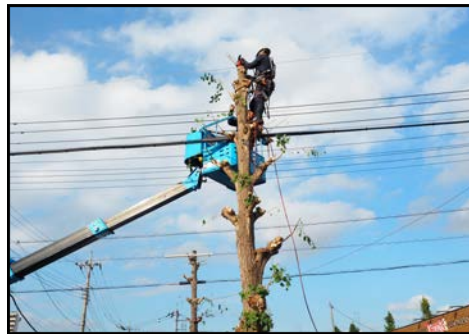
施工中（街路樹剪定）
