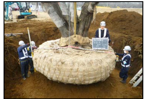
施工中（大径木移植）
